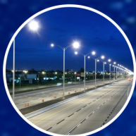
道路照明TI
